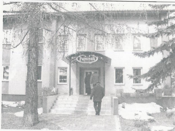
Wejście do budynku biurowego
